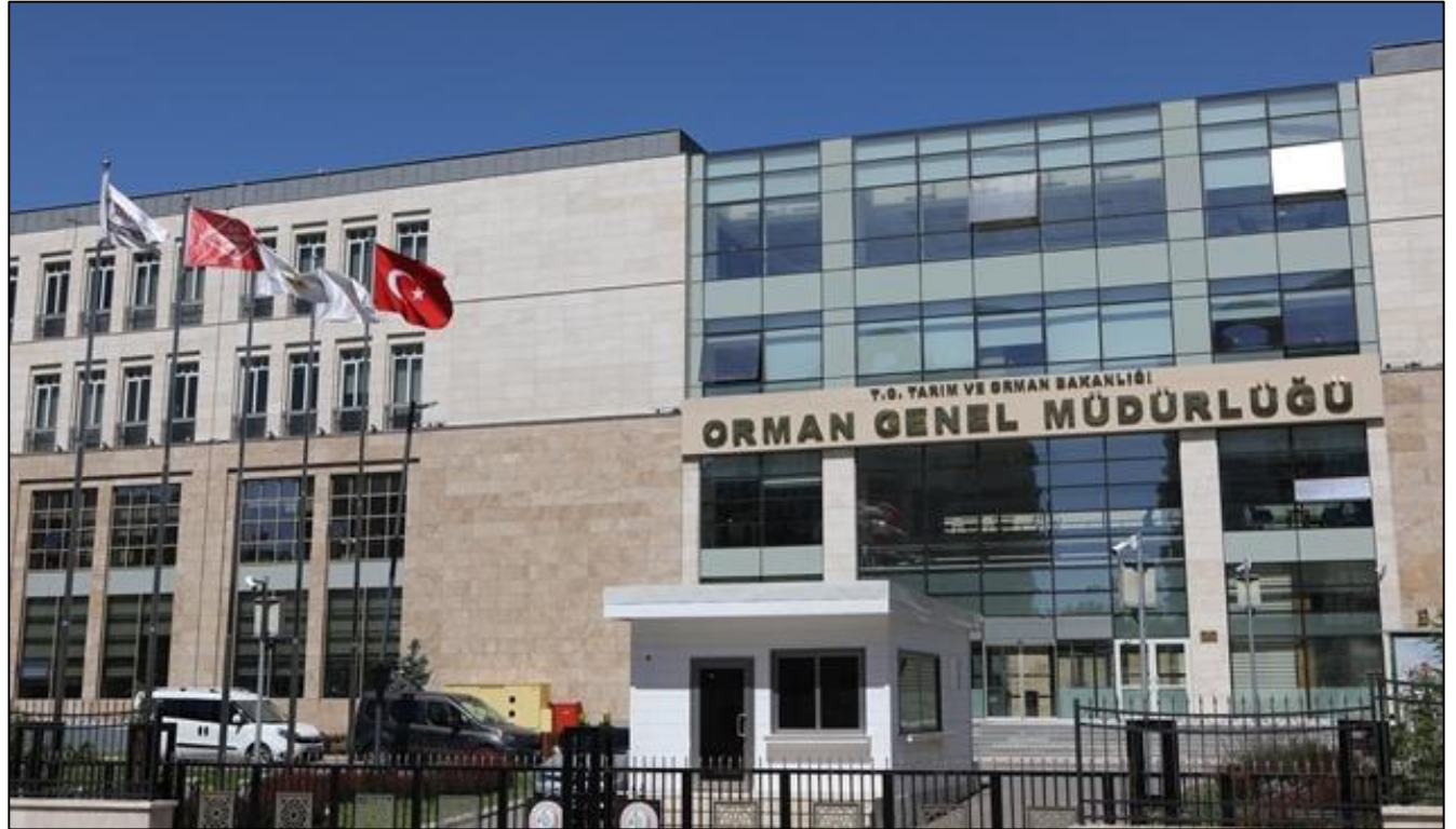
Orman Genel Müdürlüğü hizmet binası, Ankara.
