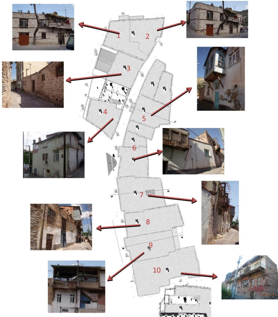
Şekil 2. Çalışma alanında belirlenen 10 konut
