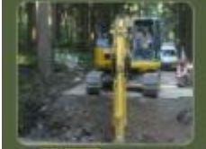
İZLEMLİ YÜKLEMEKÇİ Orman yollarının inşaatında, özellikle yolların altına drenaj kanalları kazınmasında kullanılan bir makinedir.
